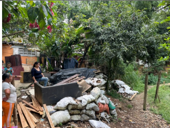
Figura 3. Acumulación de residuos de construcción y material reciclable.
